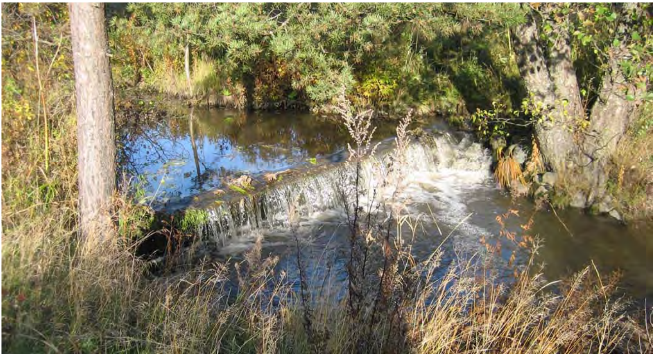
Ylisyöksypato Puolarmetsän kohdalla (kuva: FCG:n kuva-arkisto).
